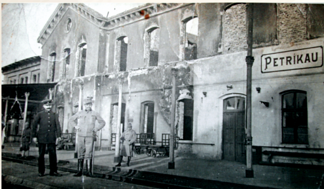
Zniszczone zabudowania dworca kolejowego w Piotrkowie.
