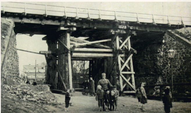
Zniszczony wiadukt kolejowy w Piotrkowie.
